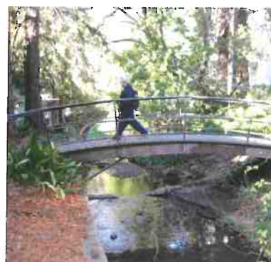
Stream Restoration Restauración de Arroyos
